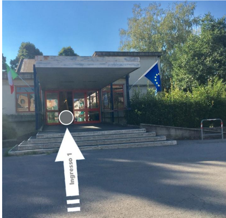
Ingresso 1: Viale Europa (ingresso principale)
